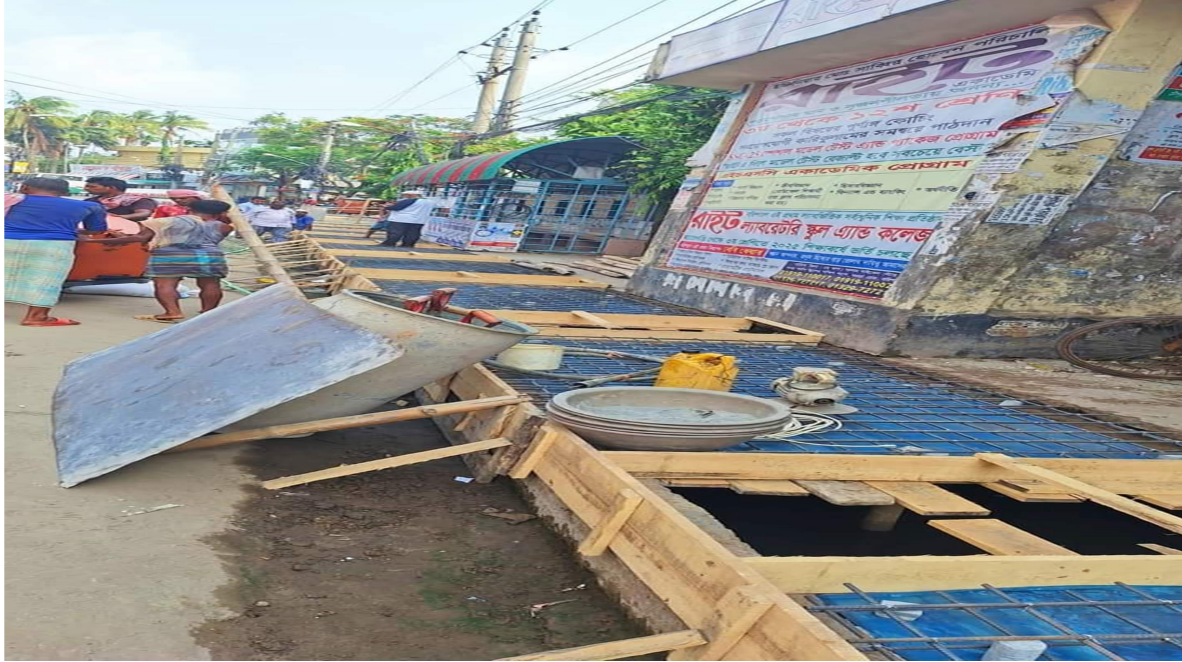
নগরীর সদর গালস স্কুলের সামনে ড্রেন নির্মাণ
