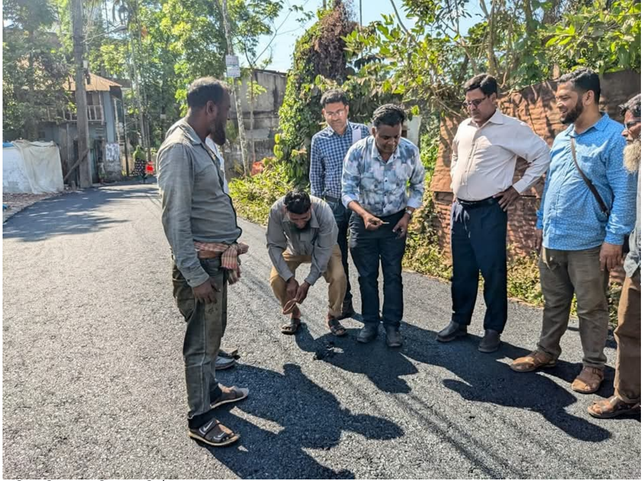
নগরীর দক্ষিণ সাগরদি রোডে নির্মাণ কাজের গুনগত মান যাচাই
