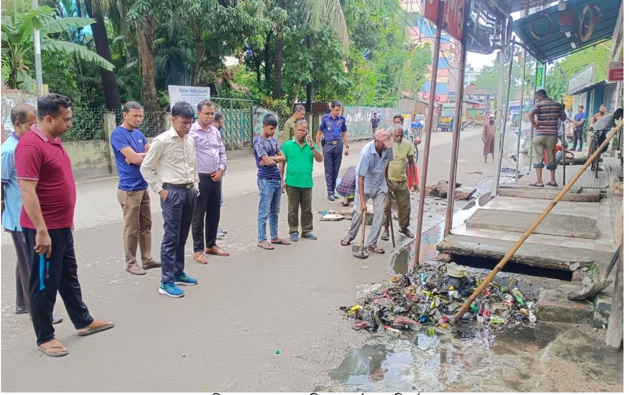
নগরীতে চলমান ড্রেন পরিষ্কার কার্যক্রম পরিদর্শন
