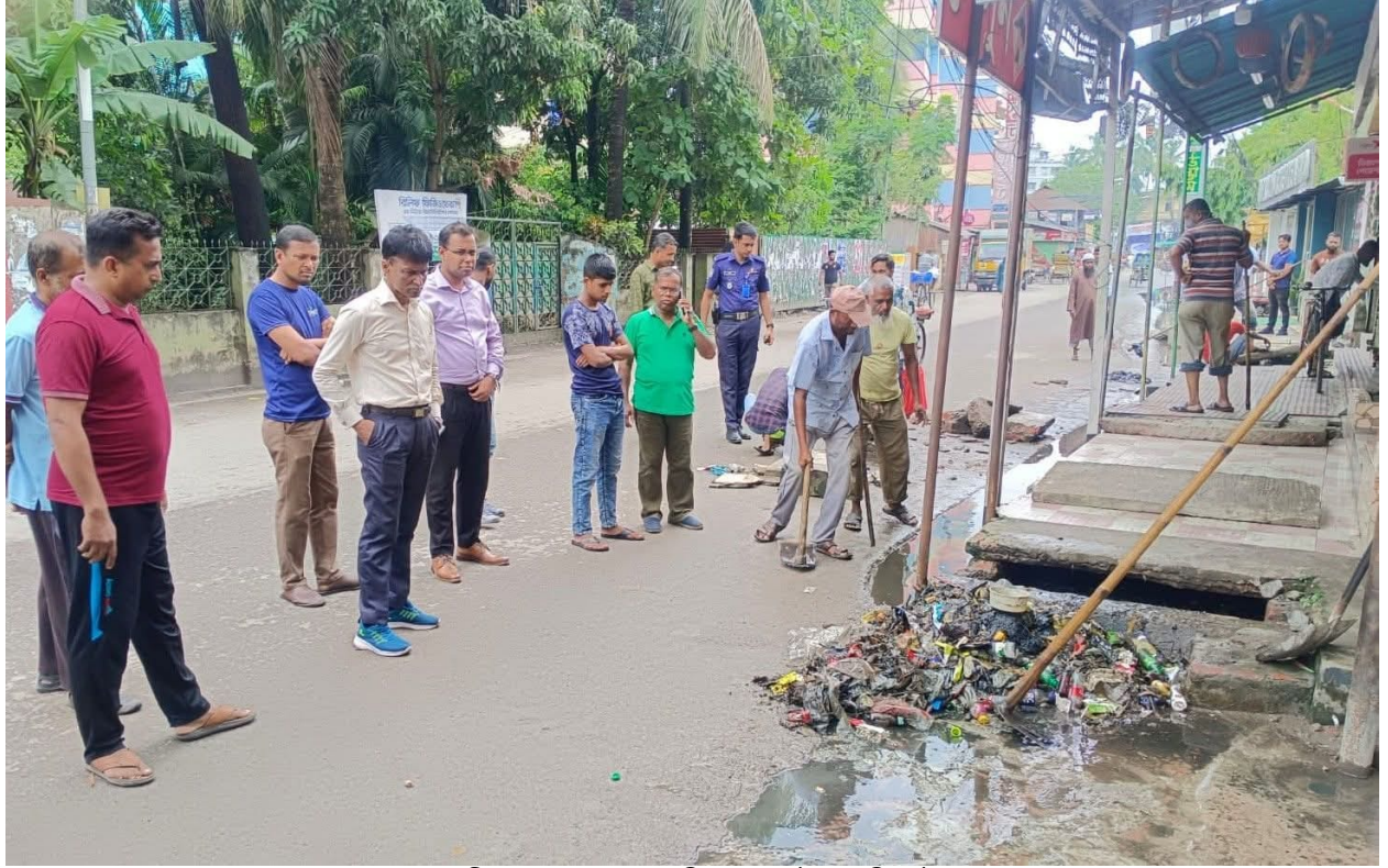
নগরীতে চলমান ড্রেন পরিষ্কার কার্যক্রম পরিদর্শন
