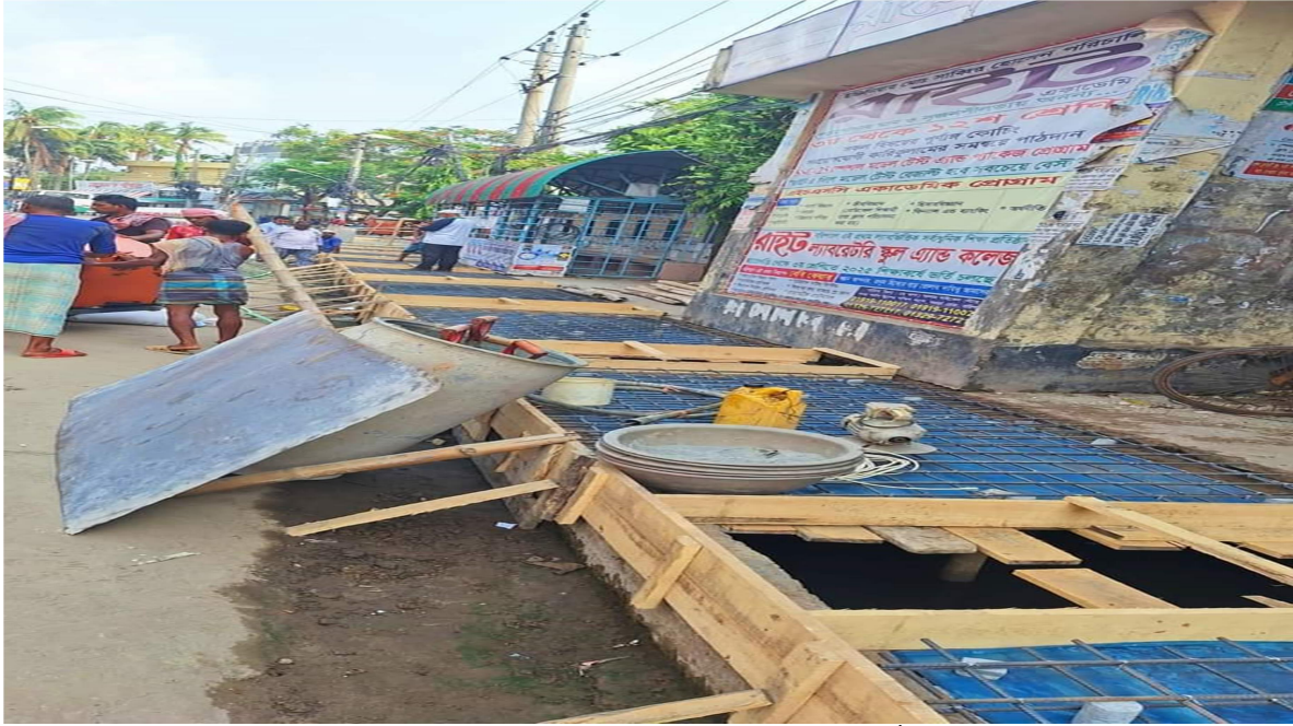
নগরীর সদর গালস স্কুলের সামনে ডেন নির্মাণ
